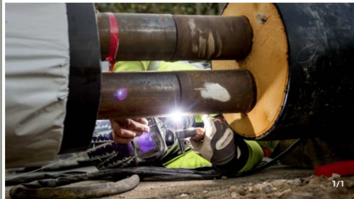
Lige nu har Vejen Varmeværk arbejde i gang på Fabriksvej i Vejen, og de næste områder, der har udsigt til at få lagt rør i jorden, er Dalgårdsvej i Vejen og Sandmarken i Askov. Arkivfoto: Morten Pape
