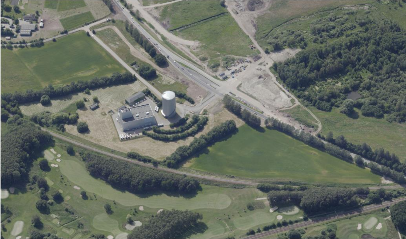
Skråfoto fra Øst - Eksisterende anlæg.
